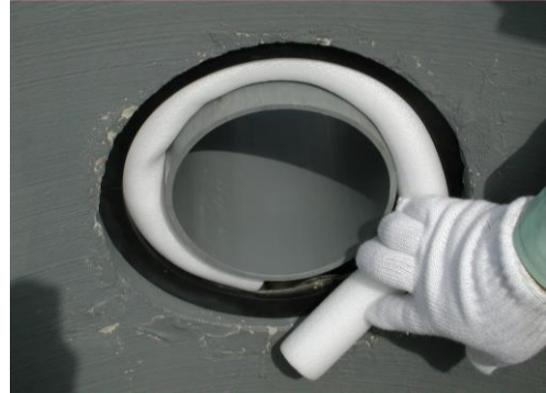
3. バックアップ材を挿入
