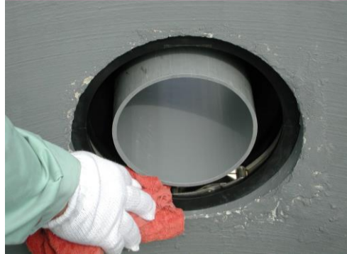
2. 削孔面の清掃
